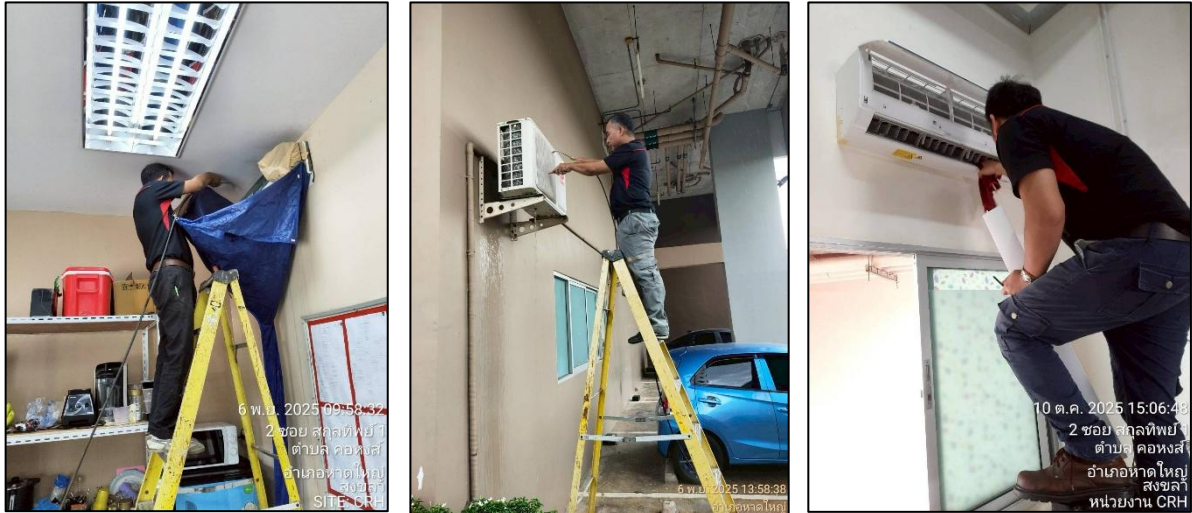
รูปภาพที่ 2.31 การทำความสะอาดระบบปรับอากาศ
