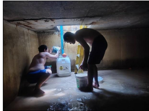
รูปภาพที่ 2.41 การล้างถังเก็บน้ำสำรอง
