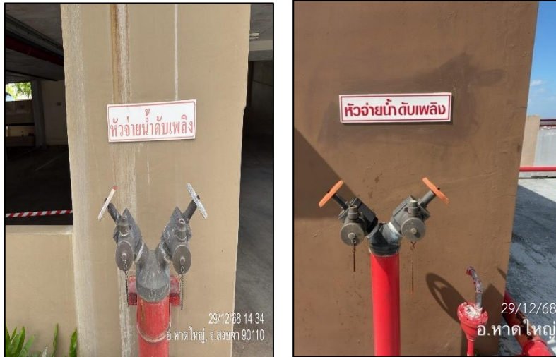
รูปภาพที่ 2.45 หัวรับน้ำและหัวจ่ายน้ำดับเพลิง
