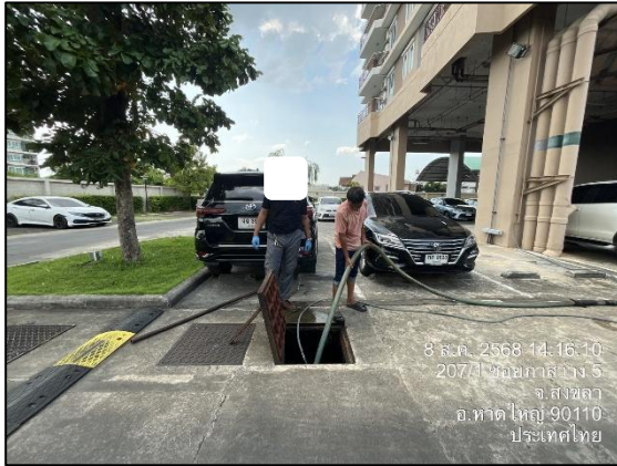
รูปภาพที่ 2.34 การสูบน้ำ
